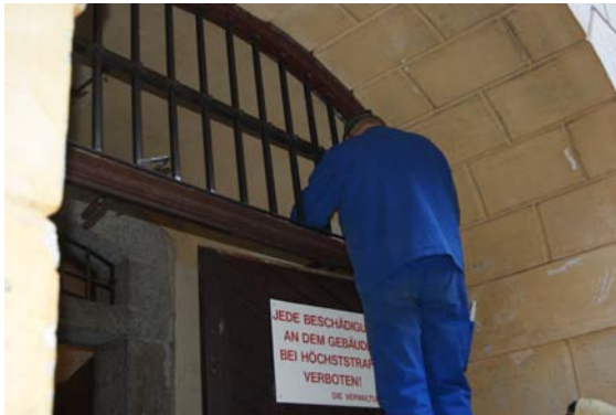
Montage des Stahlgitters am Eingang in die Kaserne
